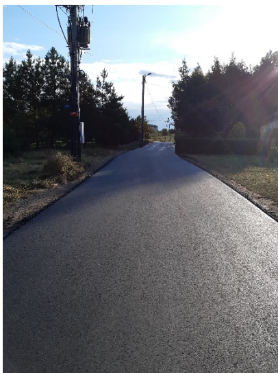
Przebudowa nawierzchni drogi gminnej w miejscowości Półwieś
