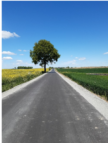
Przebudowa drogi gminnej nr 1450005N Surbajny-Międzychód
