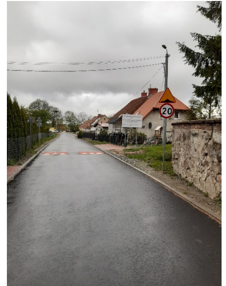
Przebudowa drogi gminnej w miejscowości Dobrzyki
