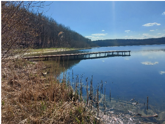
Budowa pomostu rekreacyjnego nad jeziorem Witoszewskim
