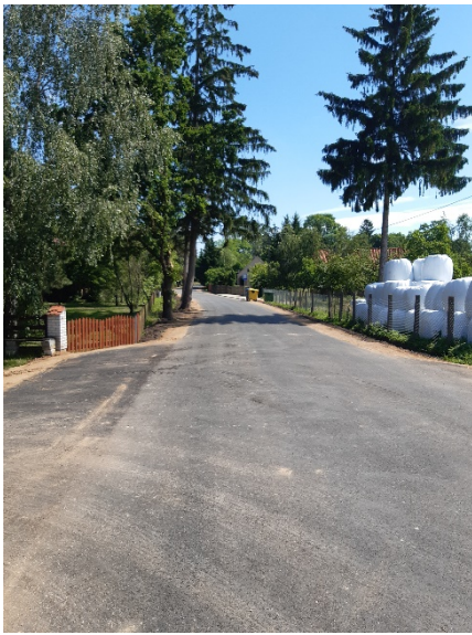
Przebudowa drogi gminnej Dobrzyki- Koziny
