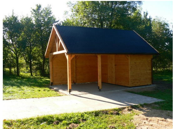
Budowa altany z pomieszczeniem gospodarczym w miejscowości Dajny
