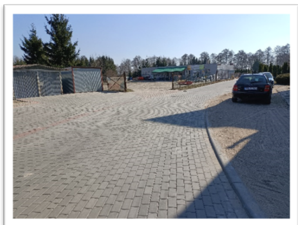
Przebudowa nawierzchni drogi wewnętrznej przy ulicy Tartacznej w Zalewie
