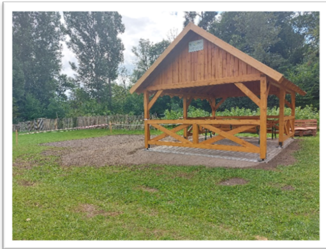
Budowa altany rekreacyjnej na plaży w Pozortach
