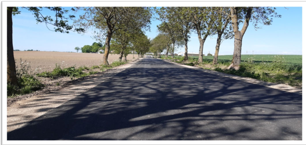
Przebudowa drogi gminnej Zatyki – Rąbity
