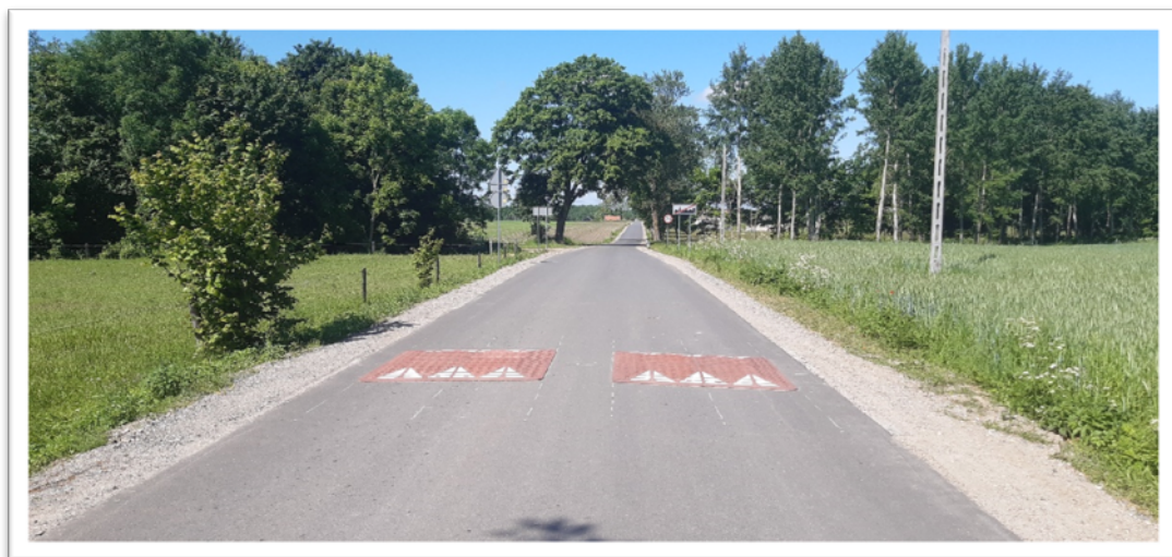
Przebudowa drogi gminnej nr 145001N Bajdy – Gajdy
