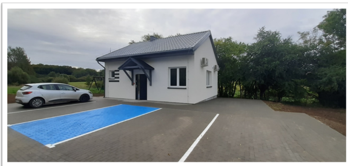
Budowa świetlicy wiejskiej w miejscowości Huta Wielka
