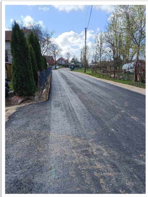
Przebudowa drogi gminnej w miejscowości Gajdy
