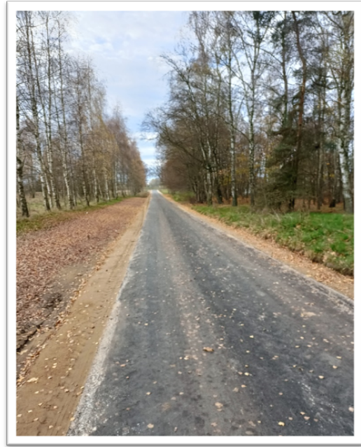
Przebudowa drogi gminnej w miejscowości Bajdy (Brzeziniak)
