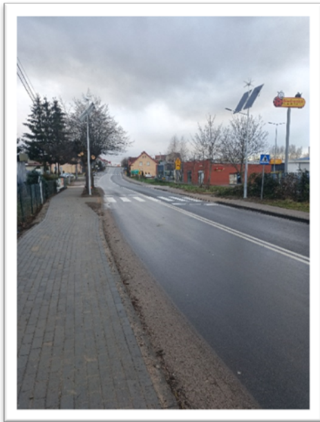
Przebudowa drogi wojewódzkiej nr 519 w zakresie budowy chodnika w miejscowości Zalewo
