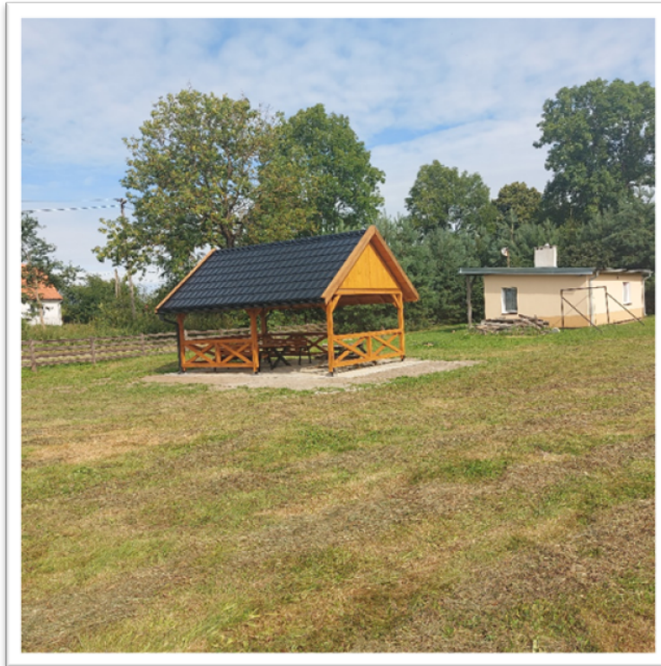
Budowa altany rekreacyjnej przy świetlicy wiejskiej w Mazankach
