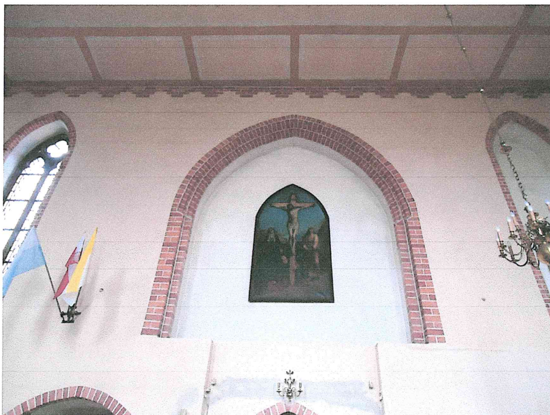
24. Widok ścian zeszlifować wtórne malowidła i wykonać malowanie farbą jak w projekcie.
