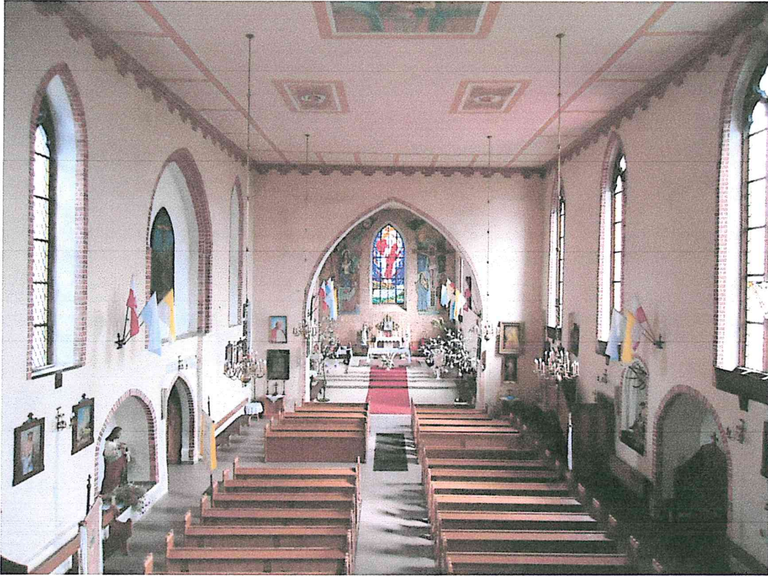
21. Widok malowideł na suficie obrazy pozostawić jak istniejące pozostałe elementy obwódki zamalować farbą do malowania wnętrza zabytkowych wg załączonego opisu w projekcie.
