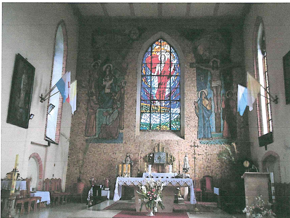
18 Widoczna mozaika na ścianie szczytowej kwalifikuje się do odbicia pozostawiając widoczne figury w miejsce odbitych miejsc wykonać tynk wapienny według załączonego w projekcie opisu.
